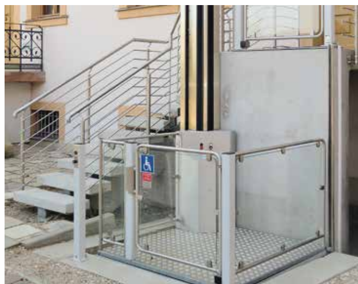
Plattformlift/Hebebühne zur Eingangstür © Frank Duphorn, Duphorn Hebelifttechnik
